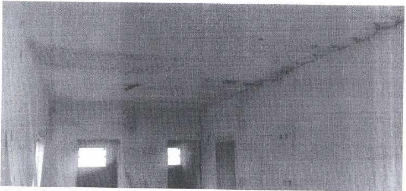
Foto 03: Recepção – para instalação de gesso rebaixado
