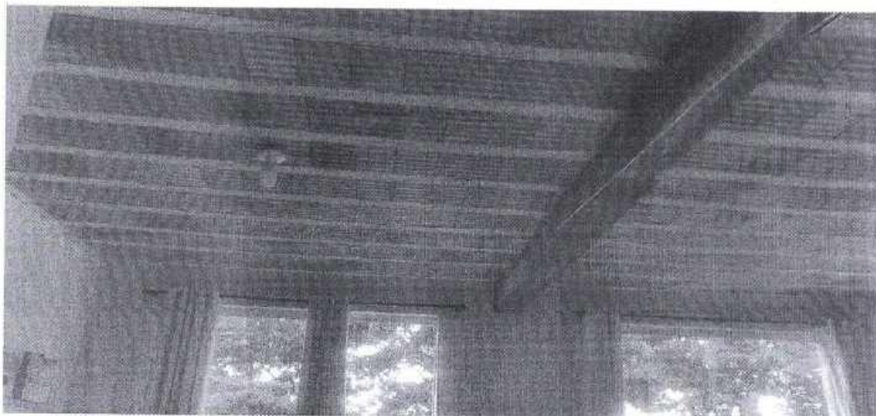
Foto 07: sala 05 – para instalação de gesso rebaixado
