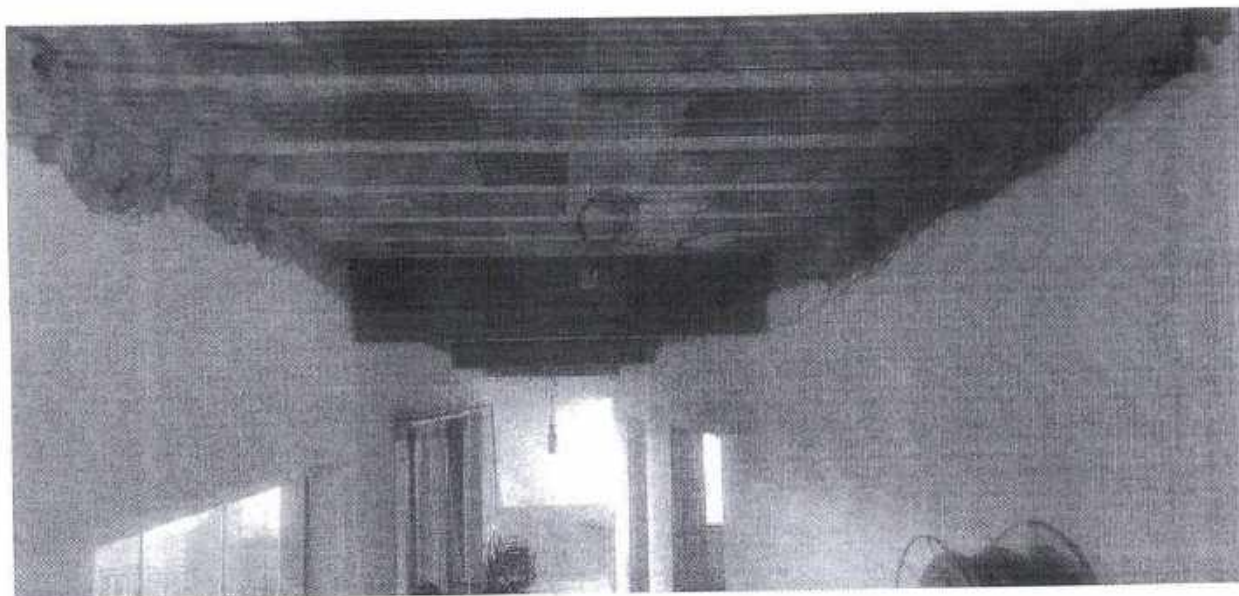
Foto 05: Corredor – para instalação de gesso rebaxado
