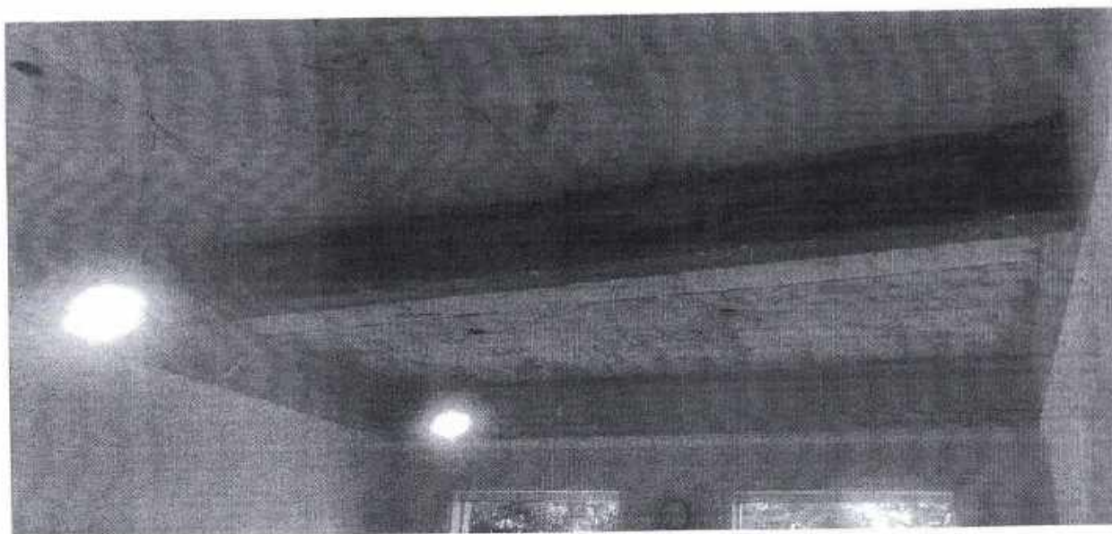
Foto 03: sala 02 – para instalação de gesso rebaixado
